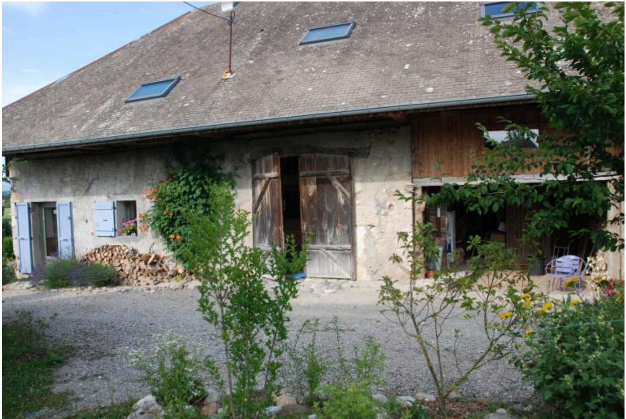
Vue d'ensemble de la grange-étable.
