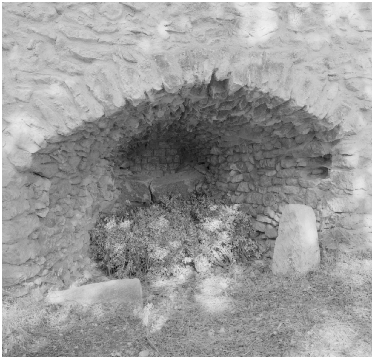
Les Erioux : l'intérieur du four à chaux dit de Bompard, récemment restauré.
