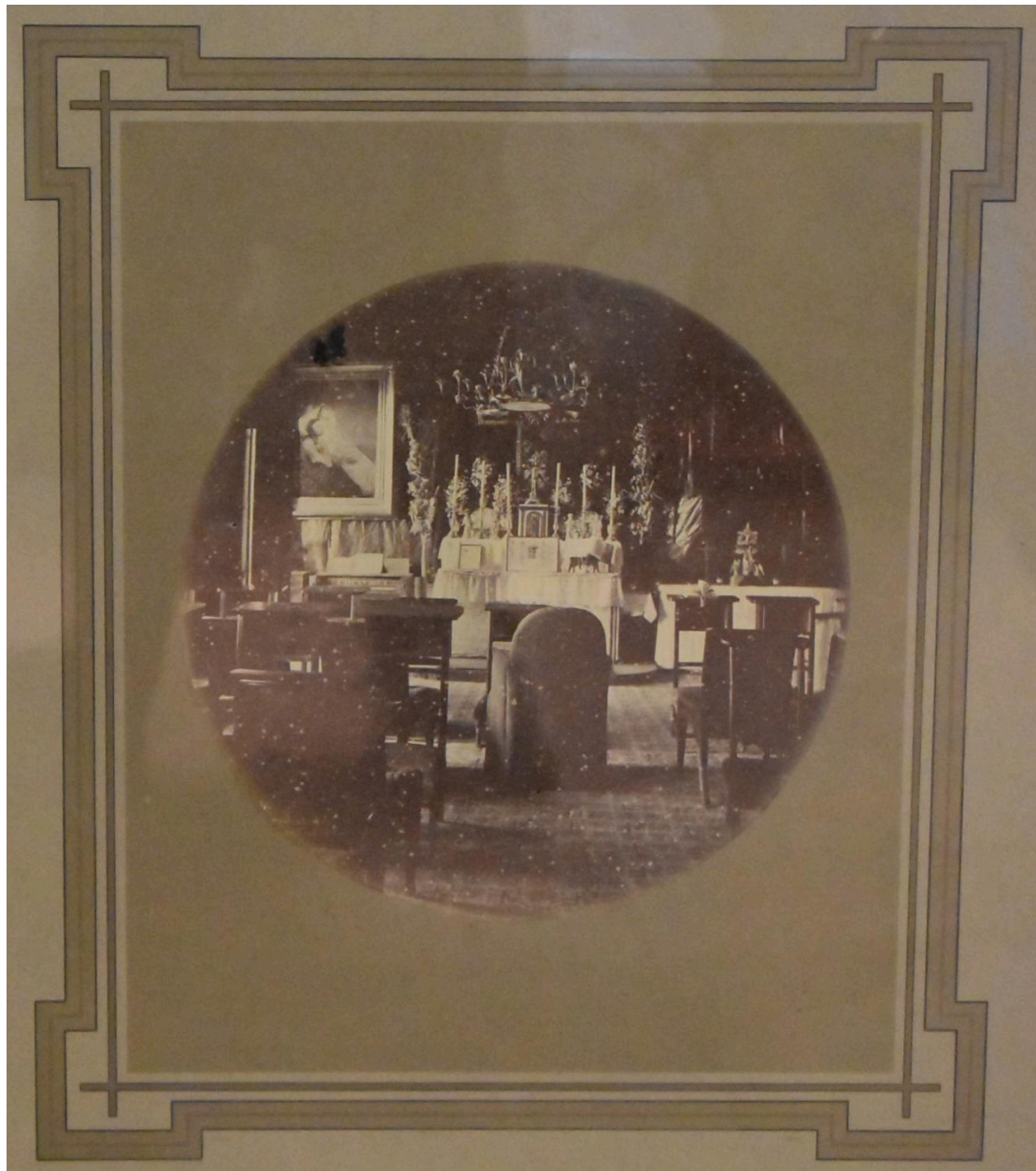
Vue du chœur de la chapelle
