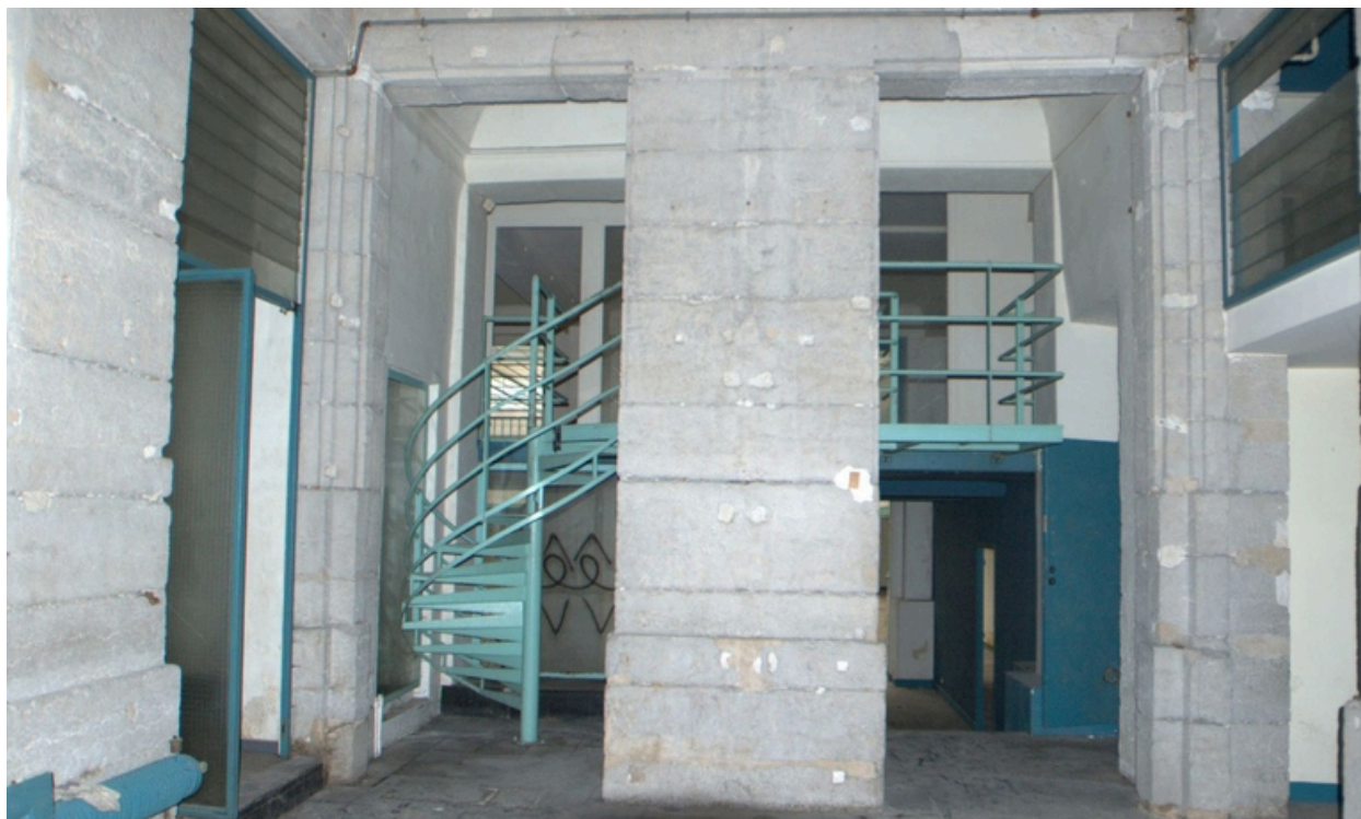
Espace connexe à la halle : avec escalier métallique
