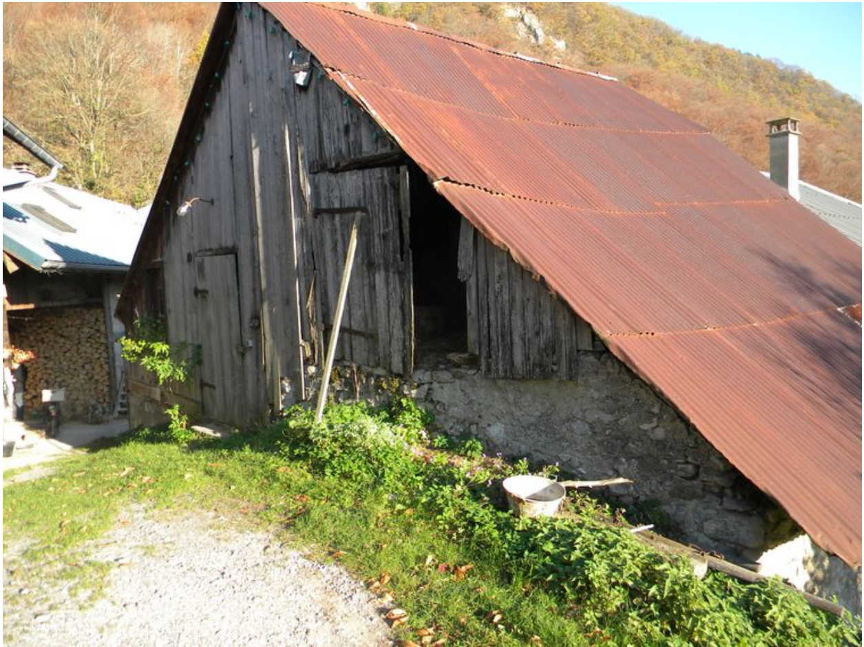
Vue d'une grange en haut du village (2008 A8 2754)
