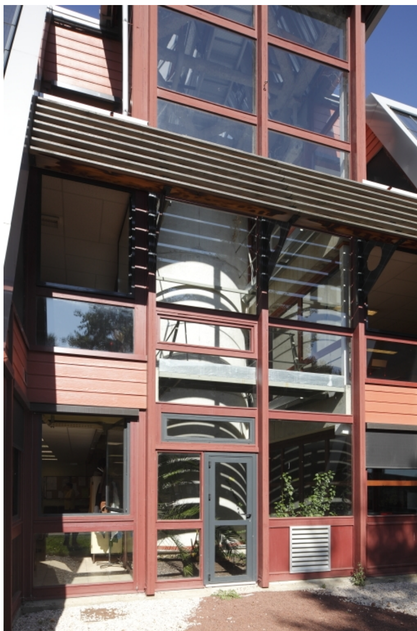
Bâtiment A, façade sud. Principe d'élévation et d'habillage autour d'une cuve de stockage et refroidissement.
