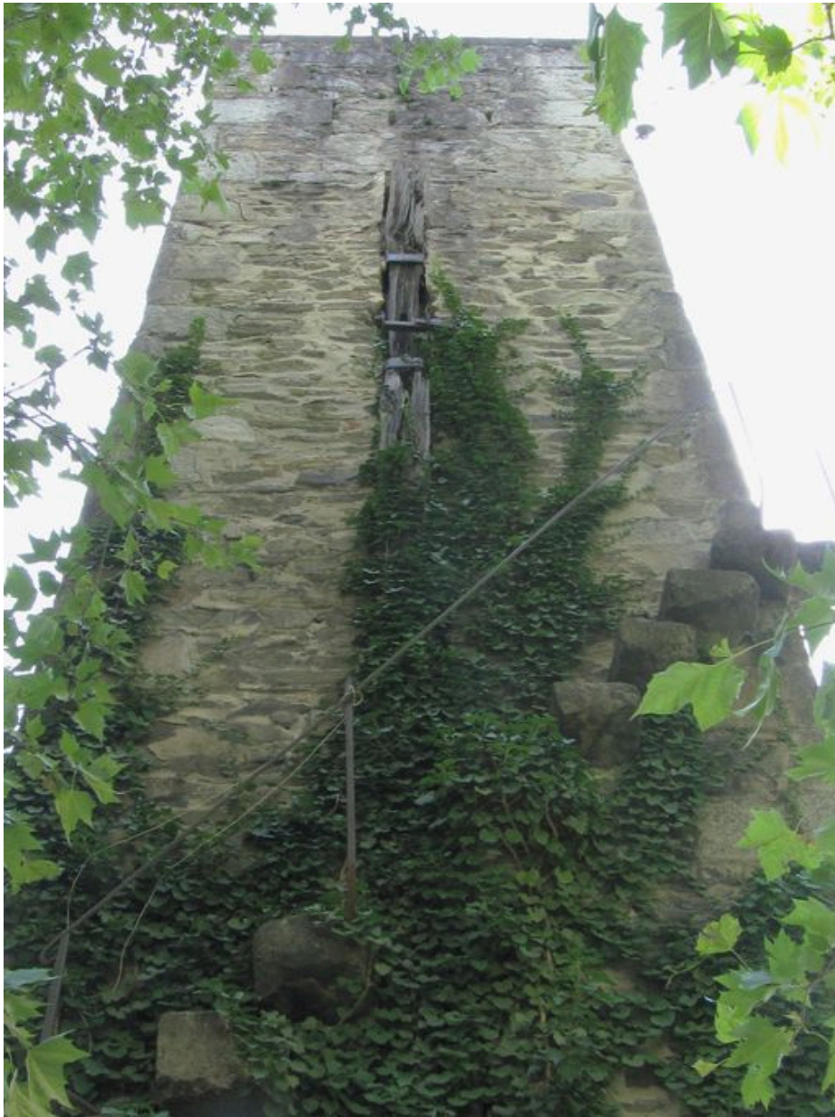
Vue partielle de la face ouest : escalier et main courante
