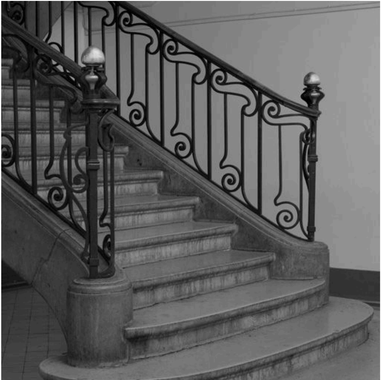
Bâtiment B, partie centrale, grand escalier, départ de rampe
