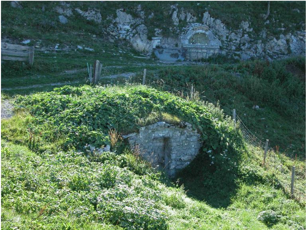
Vue de la cave enterrée avec le point d'eau en arrière plan.
