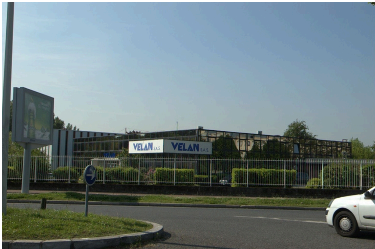
Vue générale nord avec enseigne VELAN
