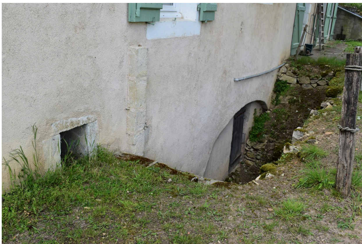
Détail de l'accès à la cave.
