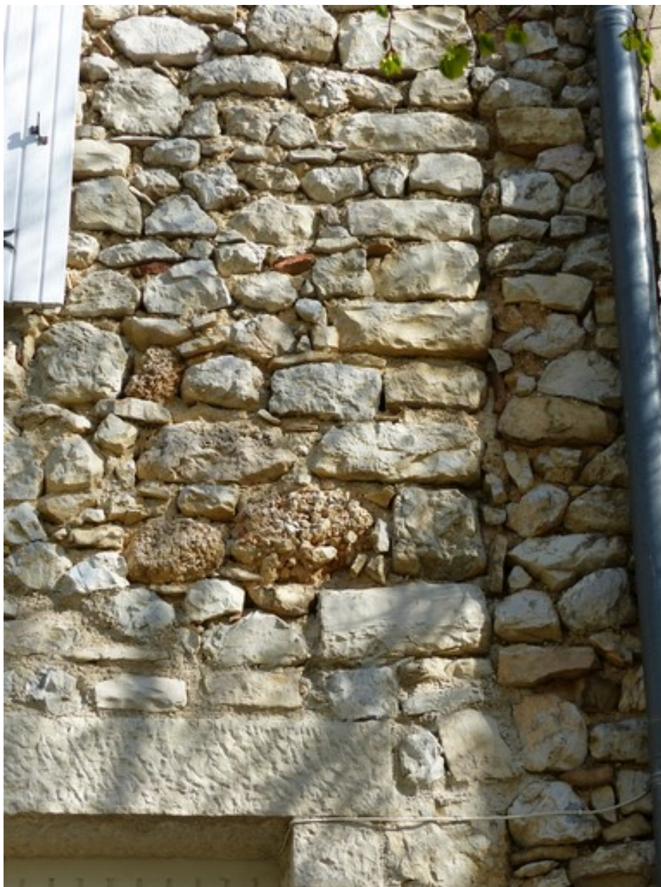
Collage de maçonnerie sur une maison au Terron.
