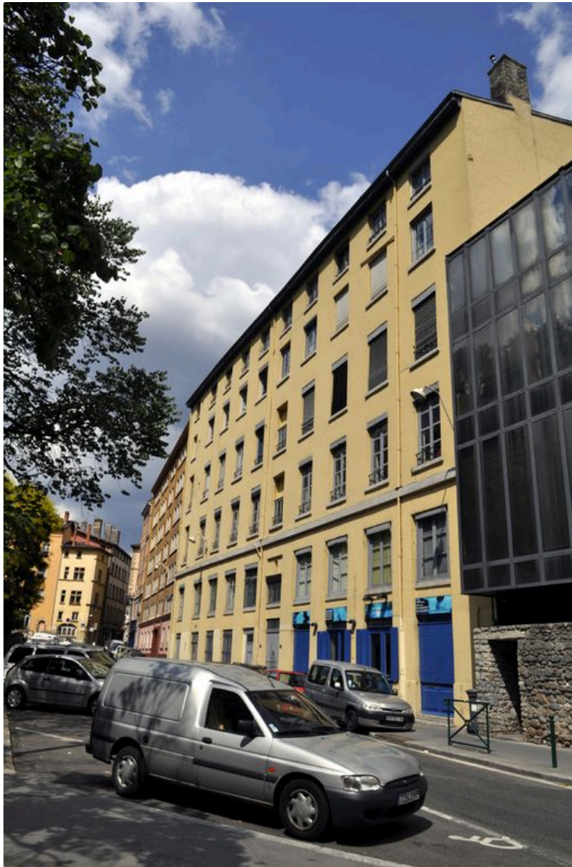
Façade rue Tramassac
