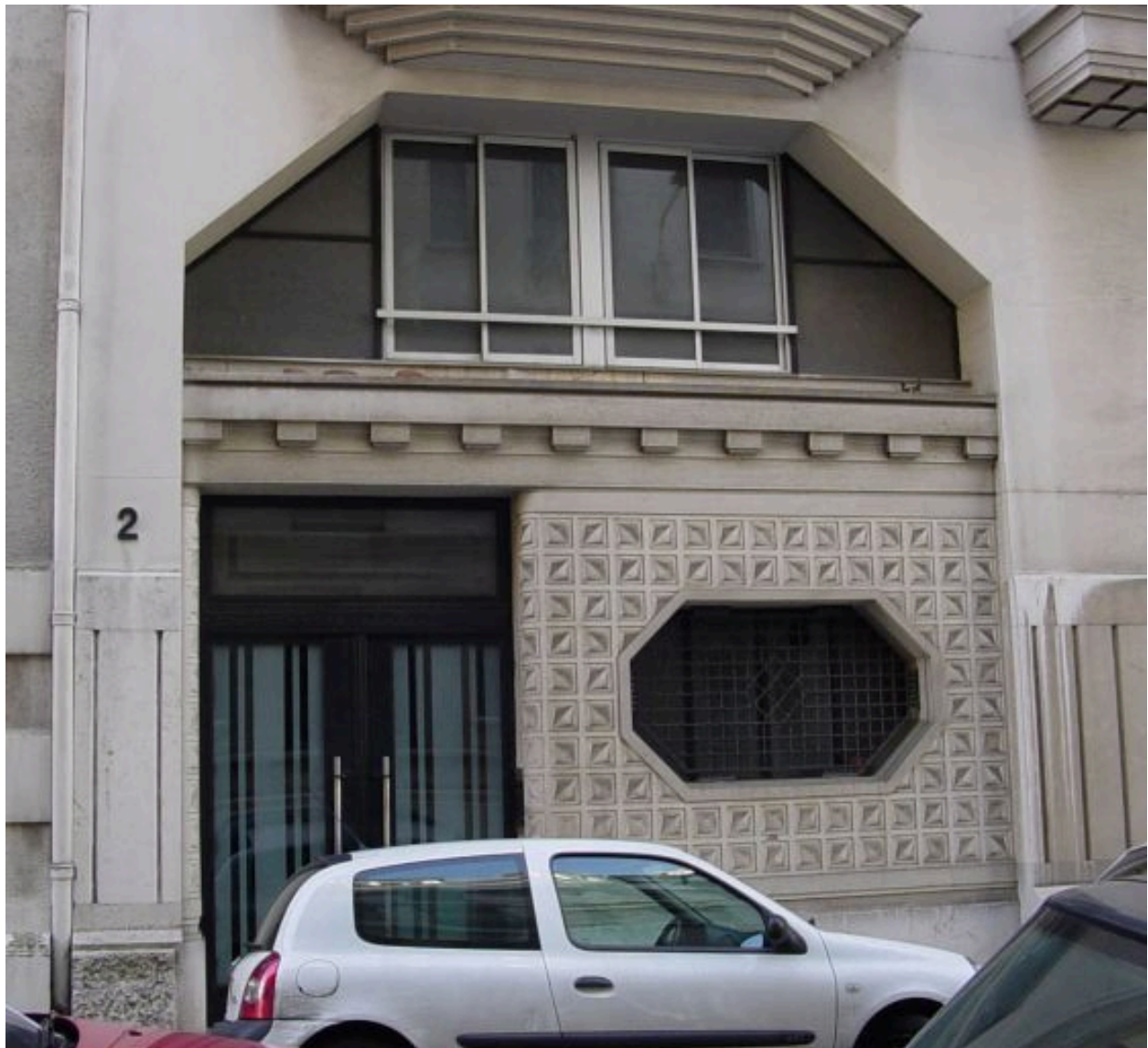
Entrée 2, rue Le Royer
