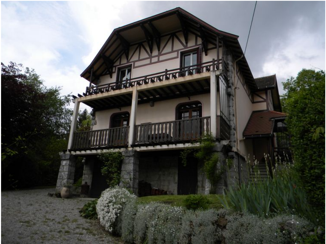
Vue de la façade principale de la villa.
