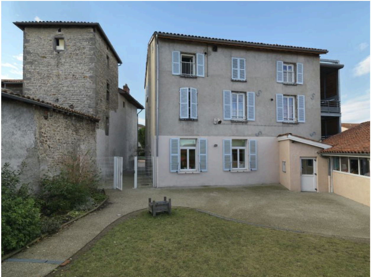
Vue d'ensemble sur cour de l'école de garçons.
