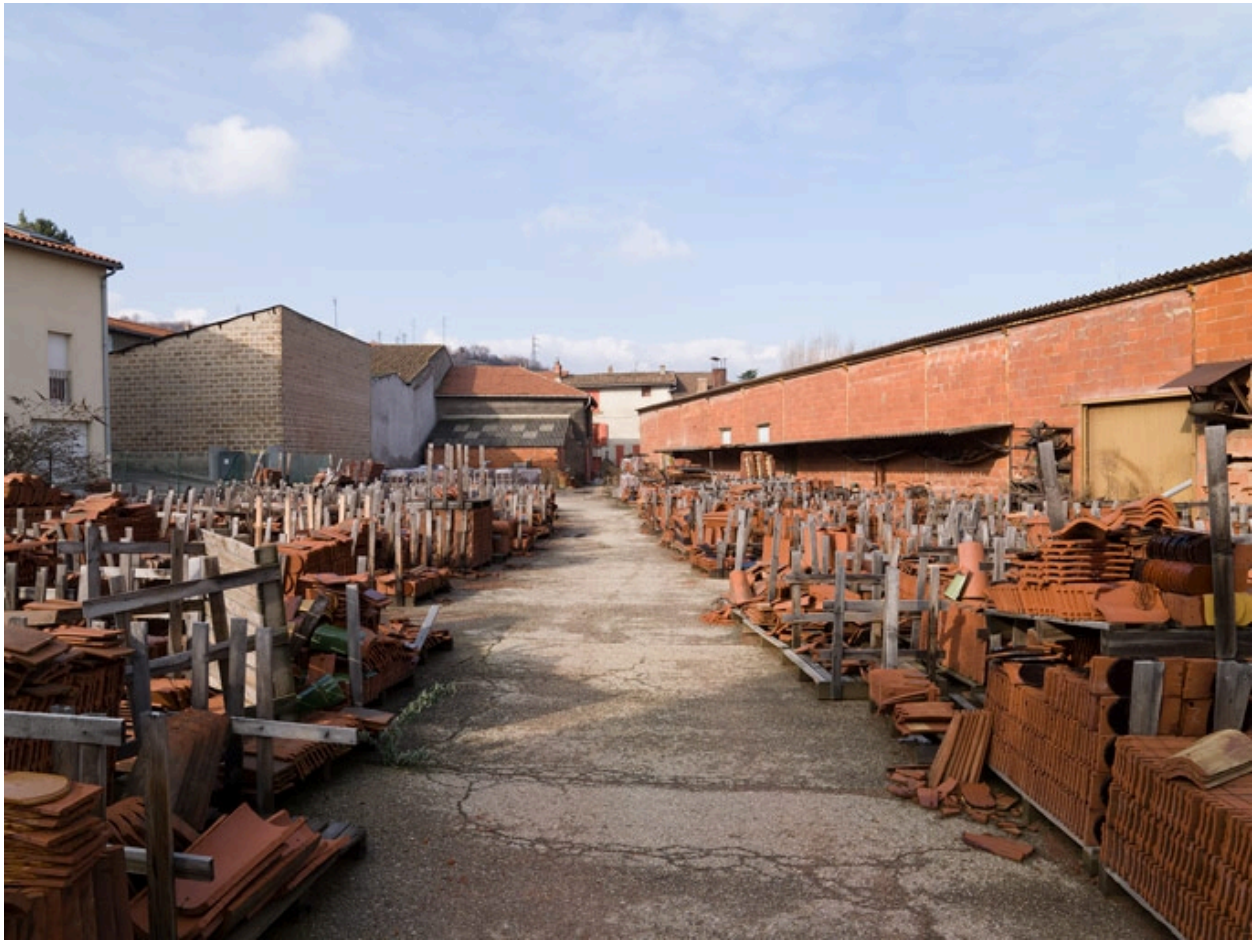
Vue générale de la première tuilerie qui va être démolie
