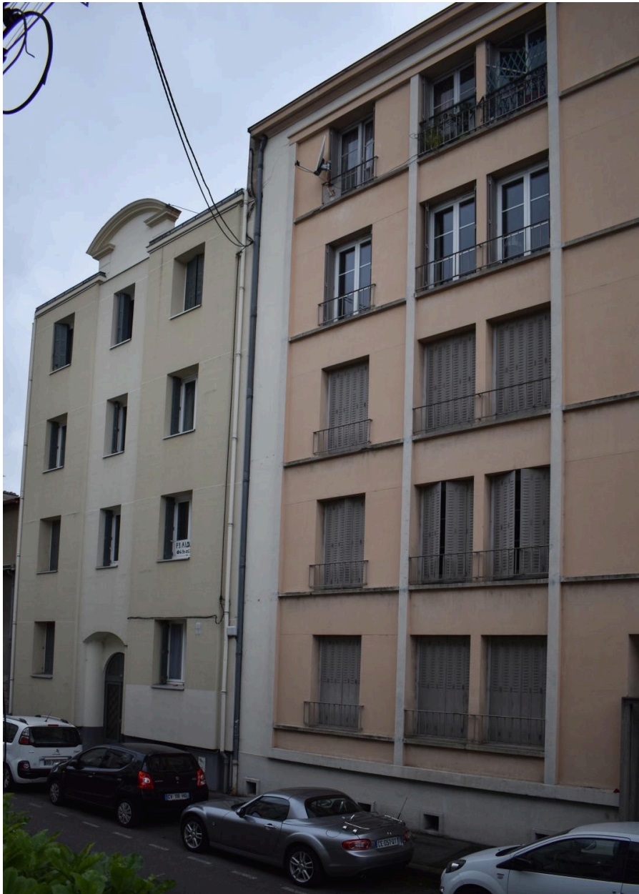
Façades sur la rue Philippe-Glangeaud
