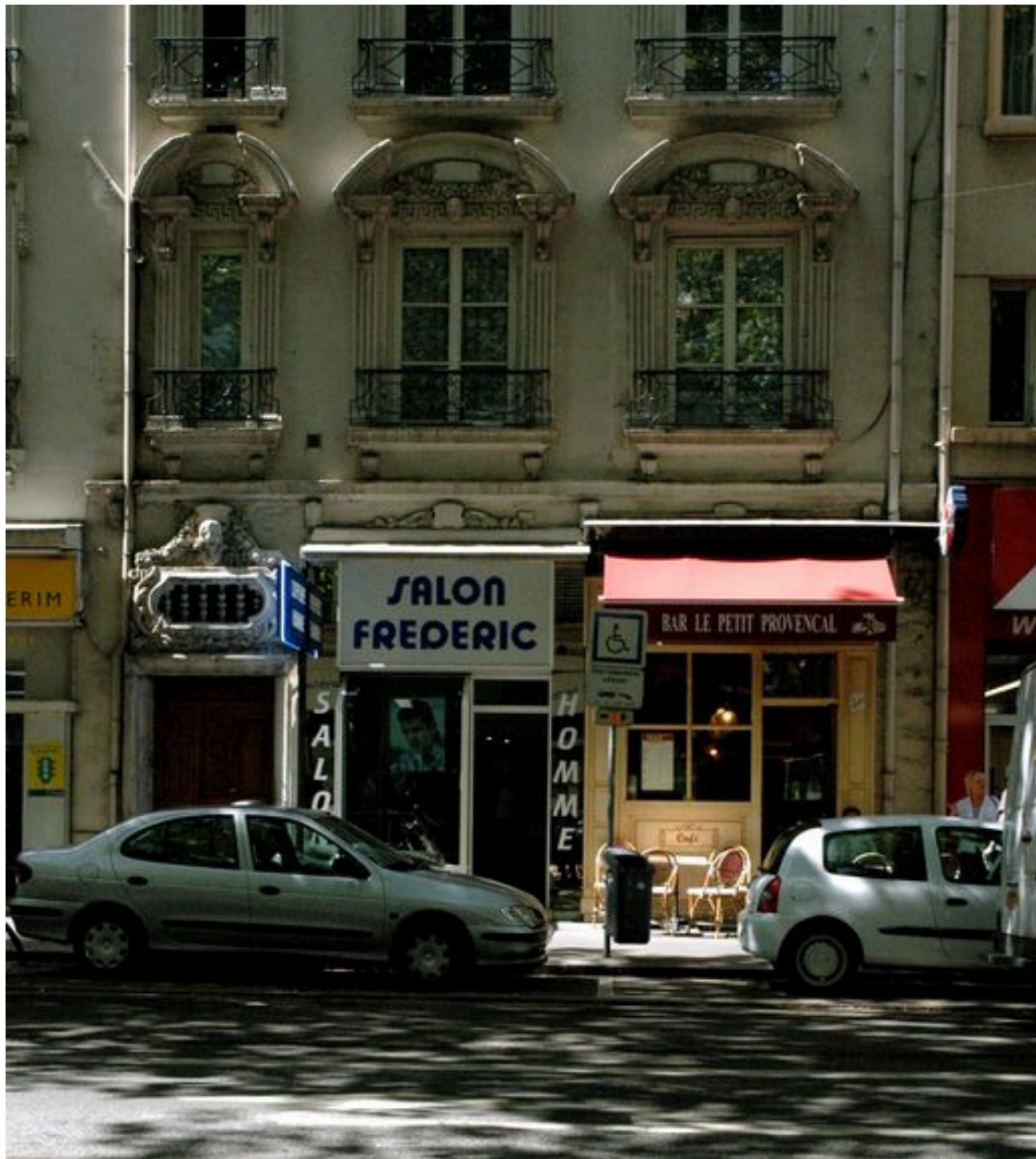
Détail du rez-de-chaussée et du 1er étage de la partie droite de l'immeuble
