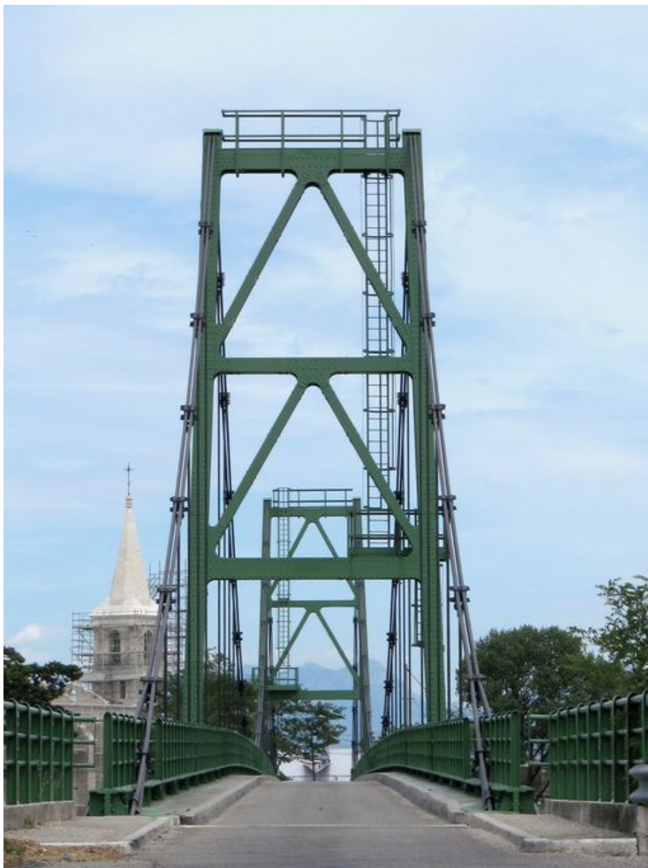
Chaussée (depuis la rive droite)
