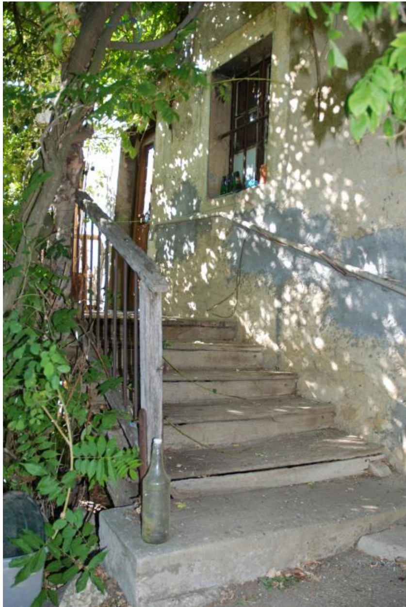
Escalier extérieur de l'habitation.
