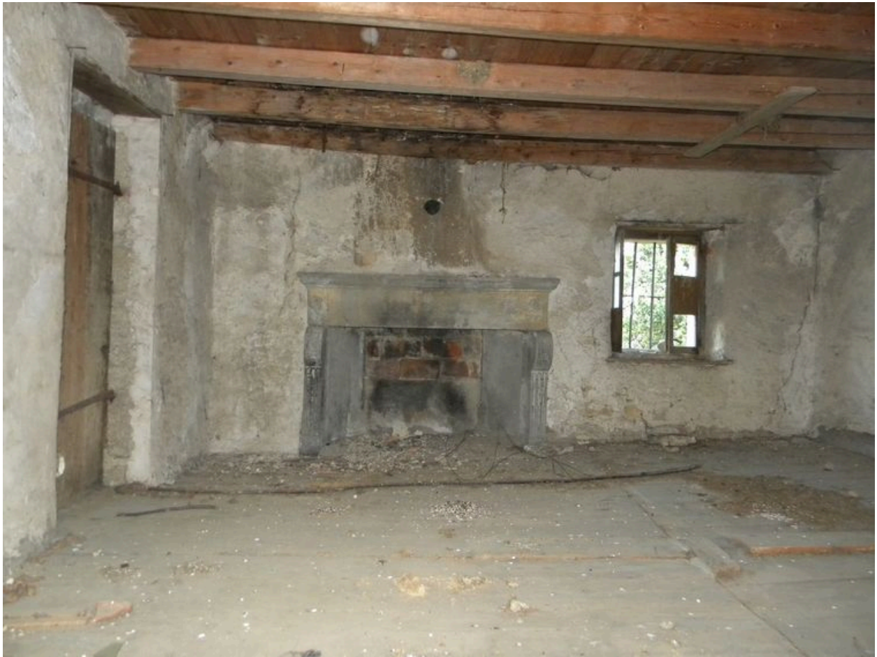
Vue de la pièce du logis avec la cheminée en molasse.
