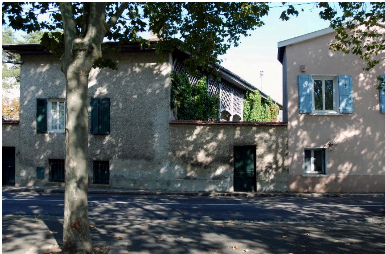
Vue d'ensemble depuis le sud-est ; à droite, l'ancienne maison du cultivateur
