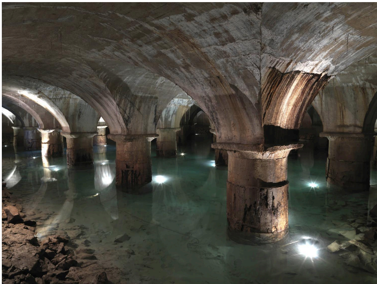
Vue des bassins filtrants
