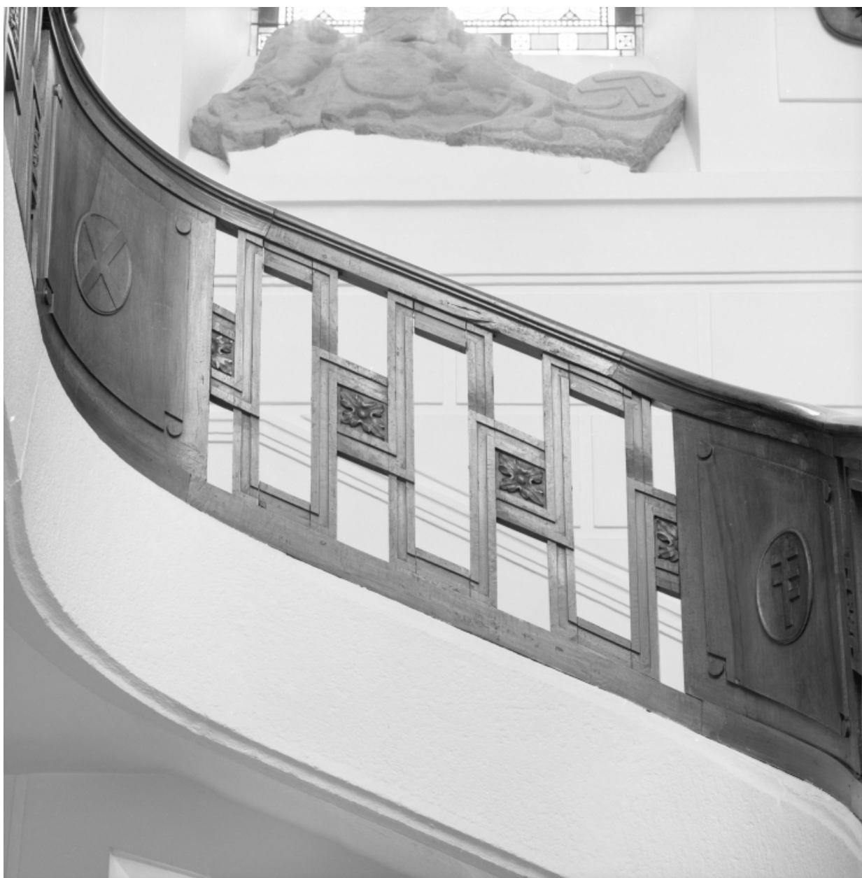
Rez-de-chaussée surélevé, escalier : détail du garde-corps de l'escalier.
