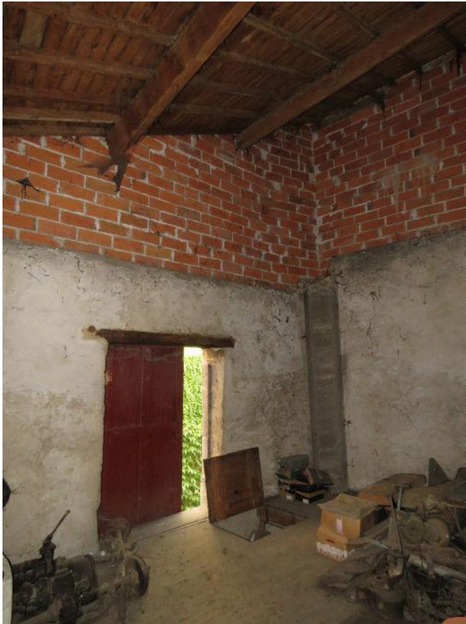
Cuvage : vue intérieure
