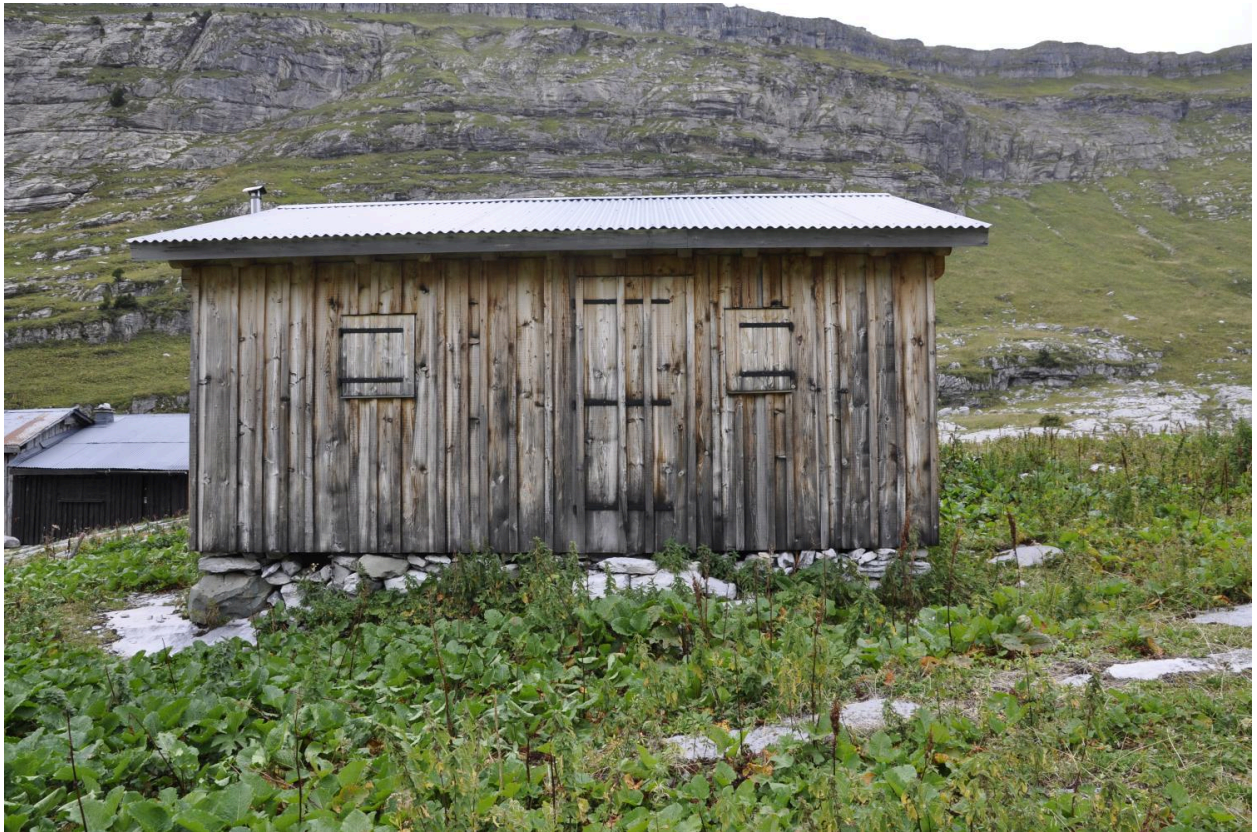
Vue de la façade antérieure est
