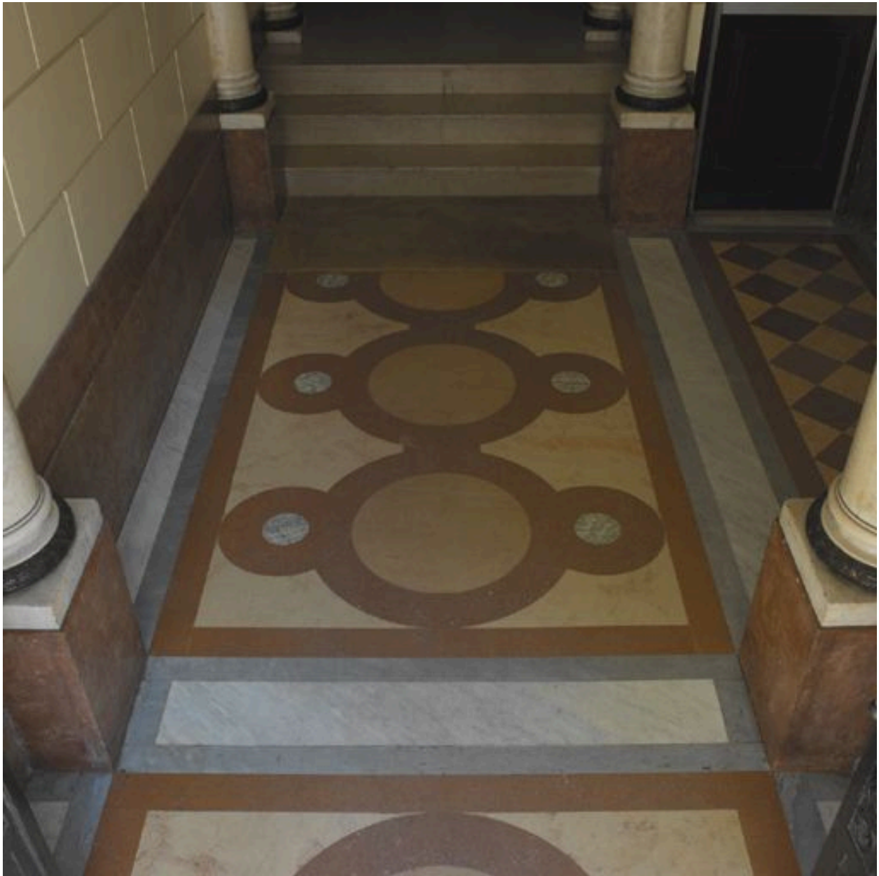
Carrelage du vestibule
