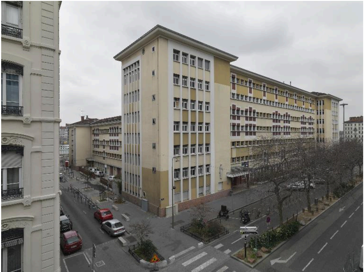
Vue générale depuis le nord-ouest
