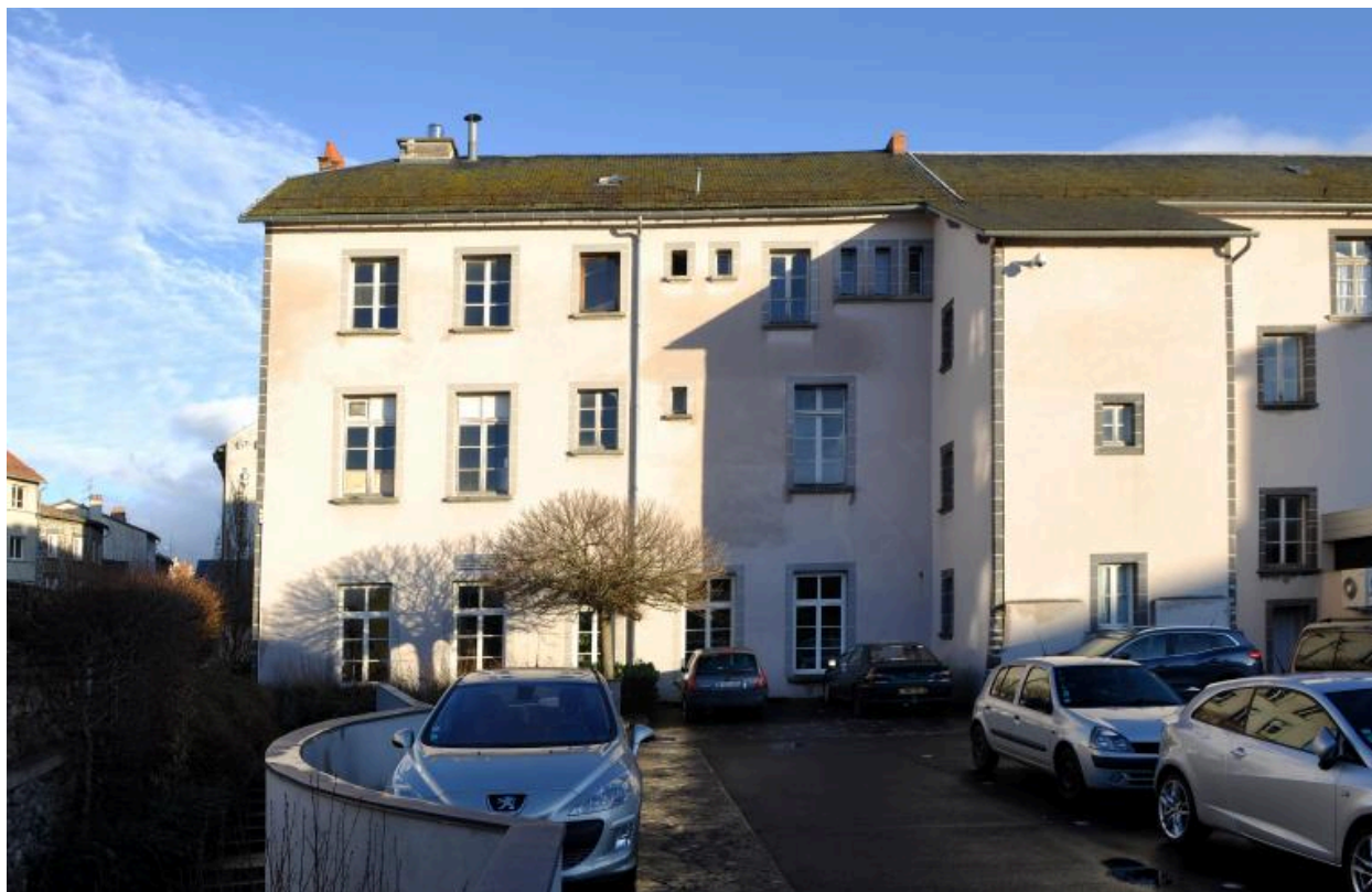
Corps de bâtiment ouest : vue partielle depuis l'ouest (extension du 19e siècle)
