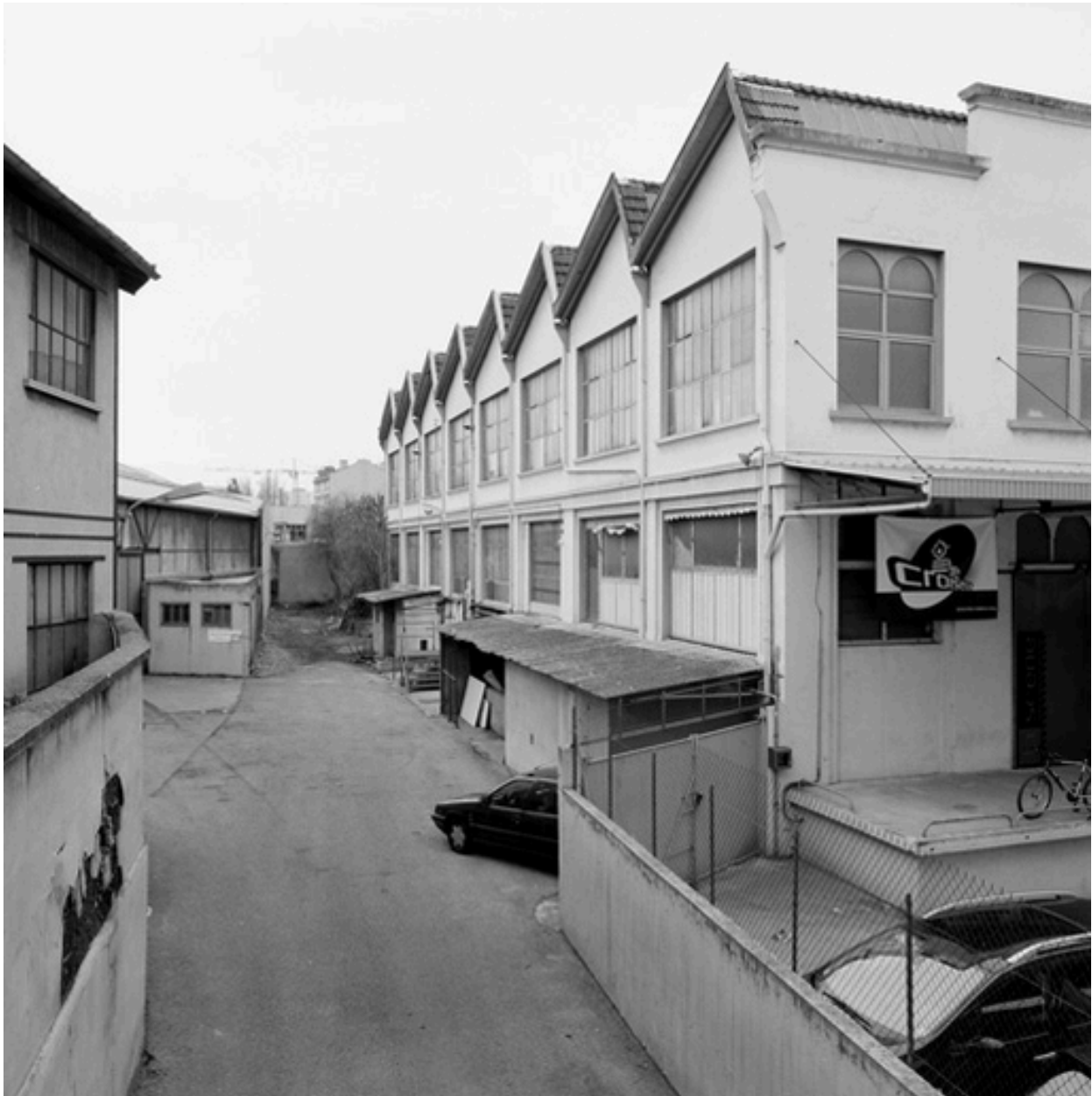
Vue d'ensemble de l'atelier principal
