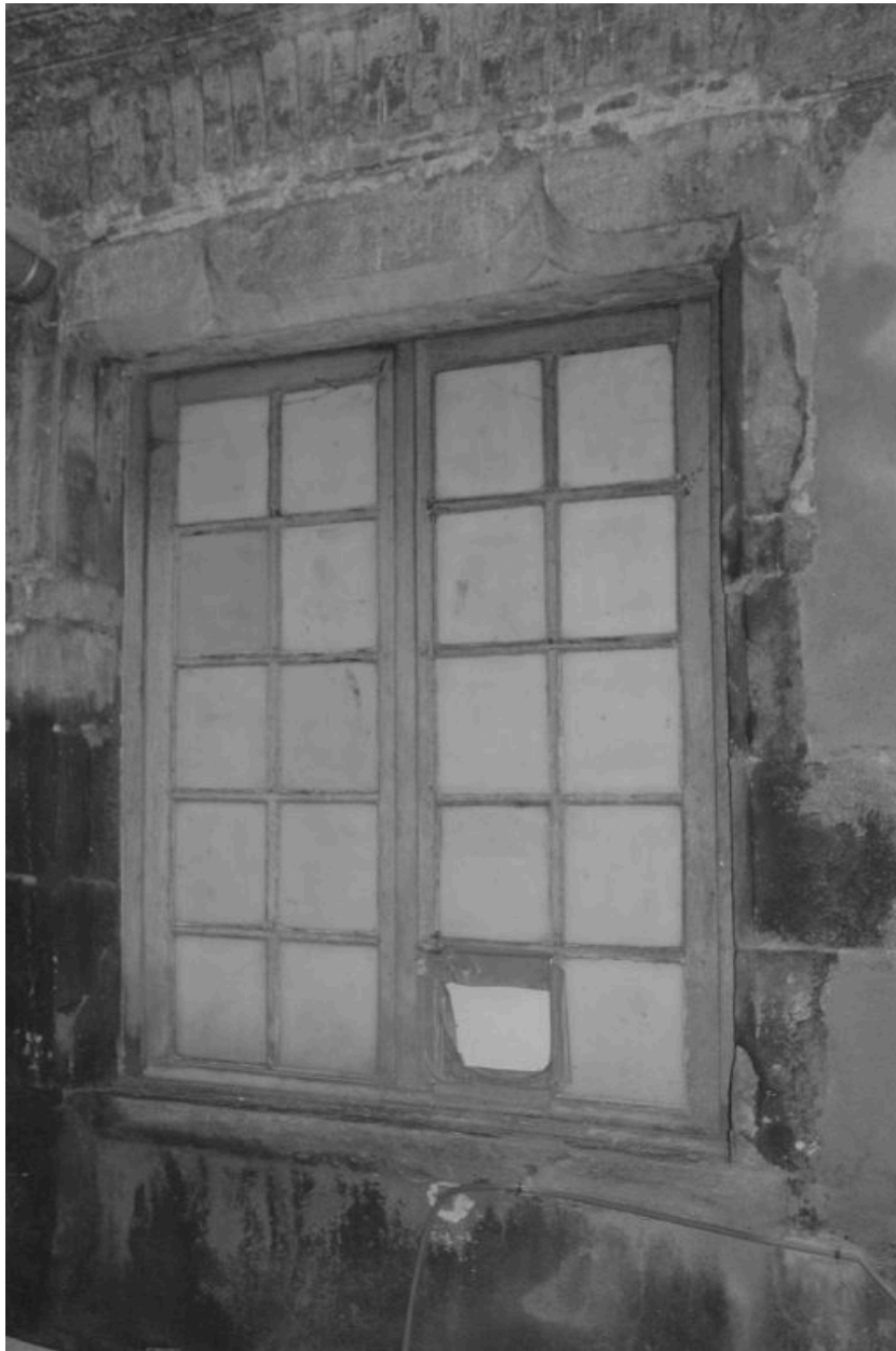
Fenêtre sur cour : linteau à double accolade (ancienne croisée), limite 15e siècle 16e siècle.
