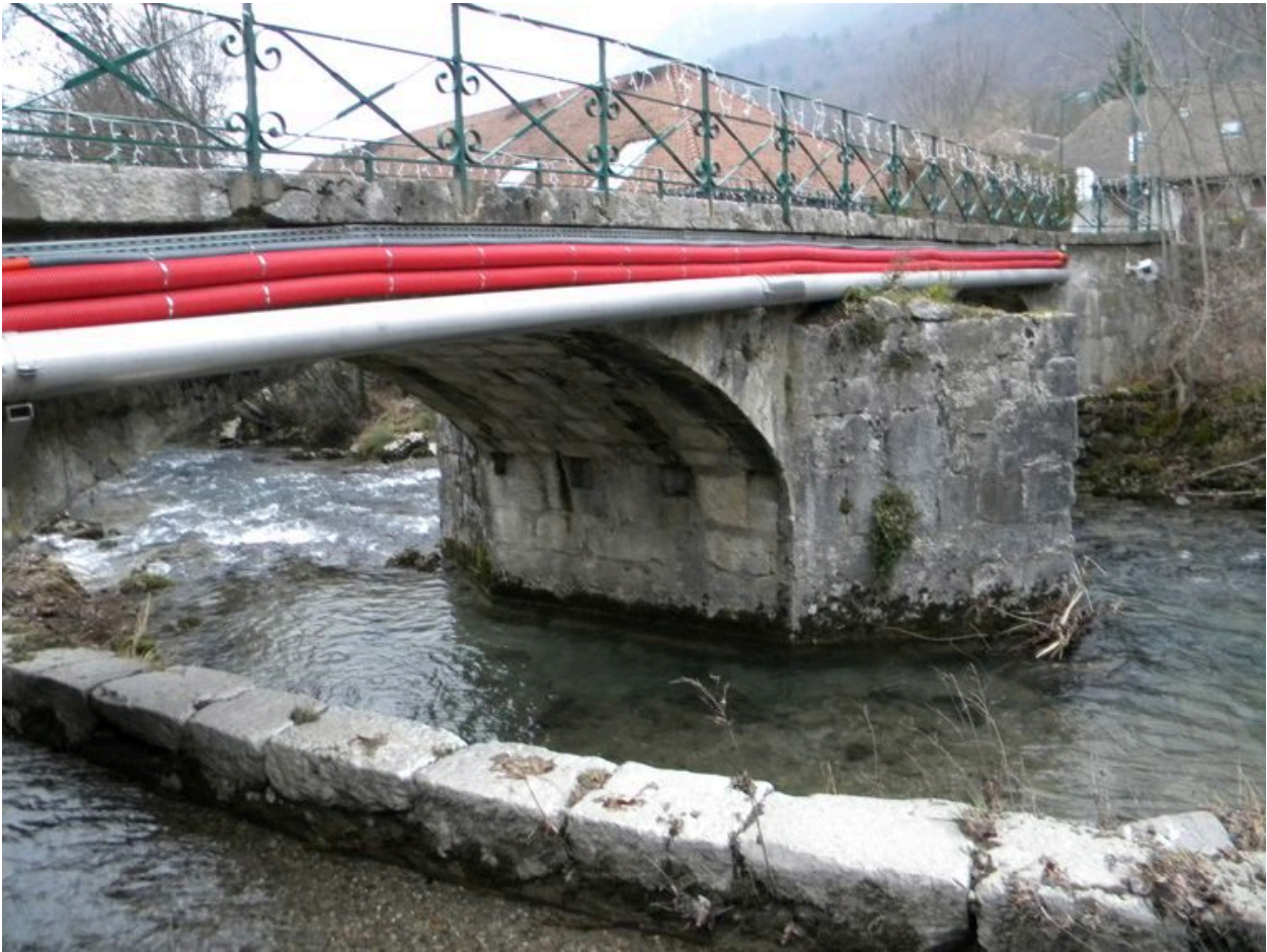
Vue générale depuis l'amont.
