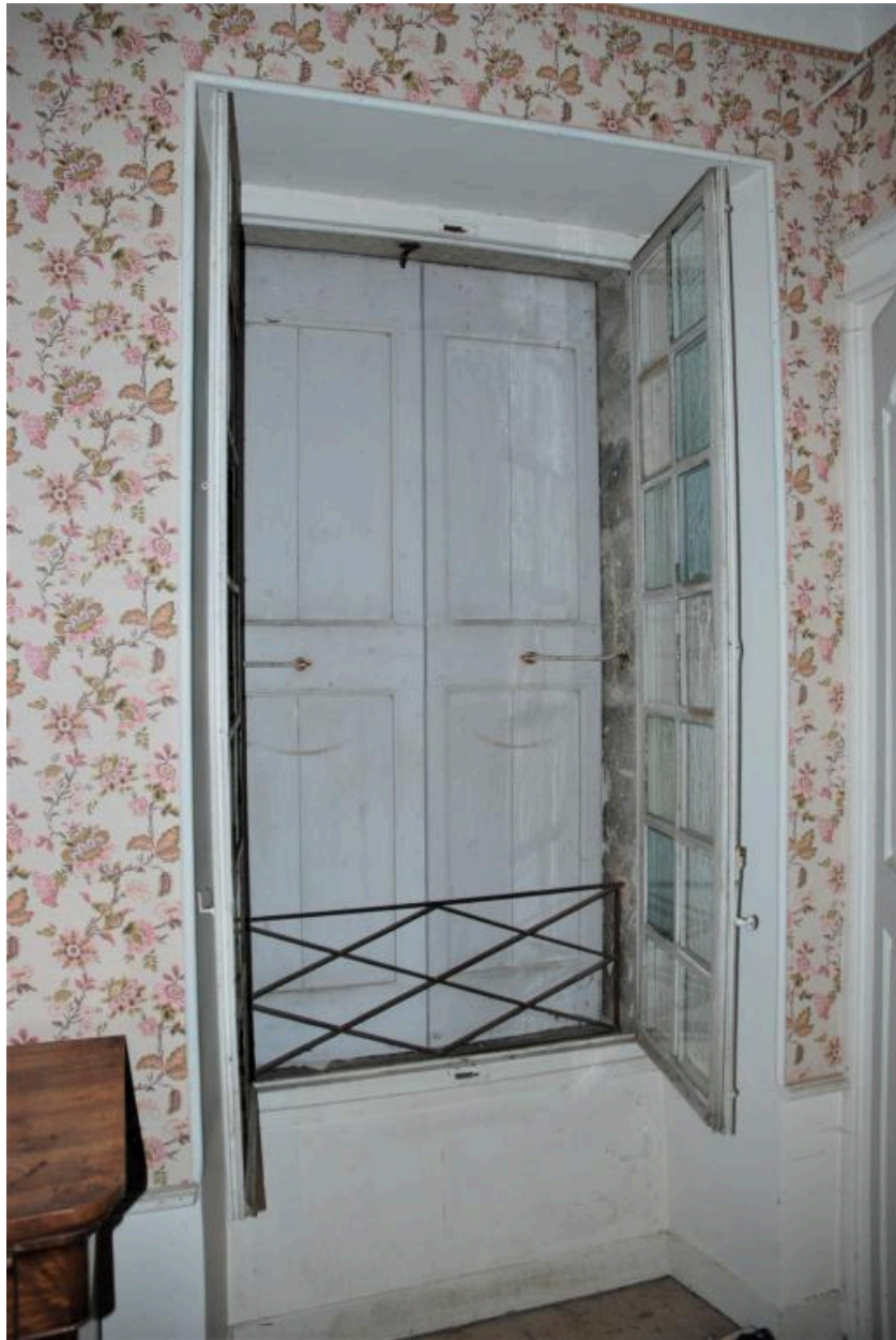
Corps principal, premier étage, partie nord, chambre (Cf. Plan étage 3), détail de la fenêtre avec garde-corps en fer forgé.
