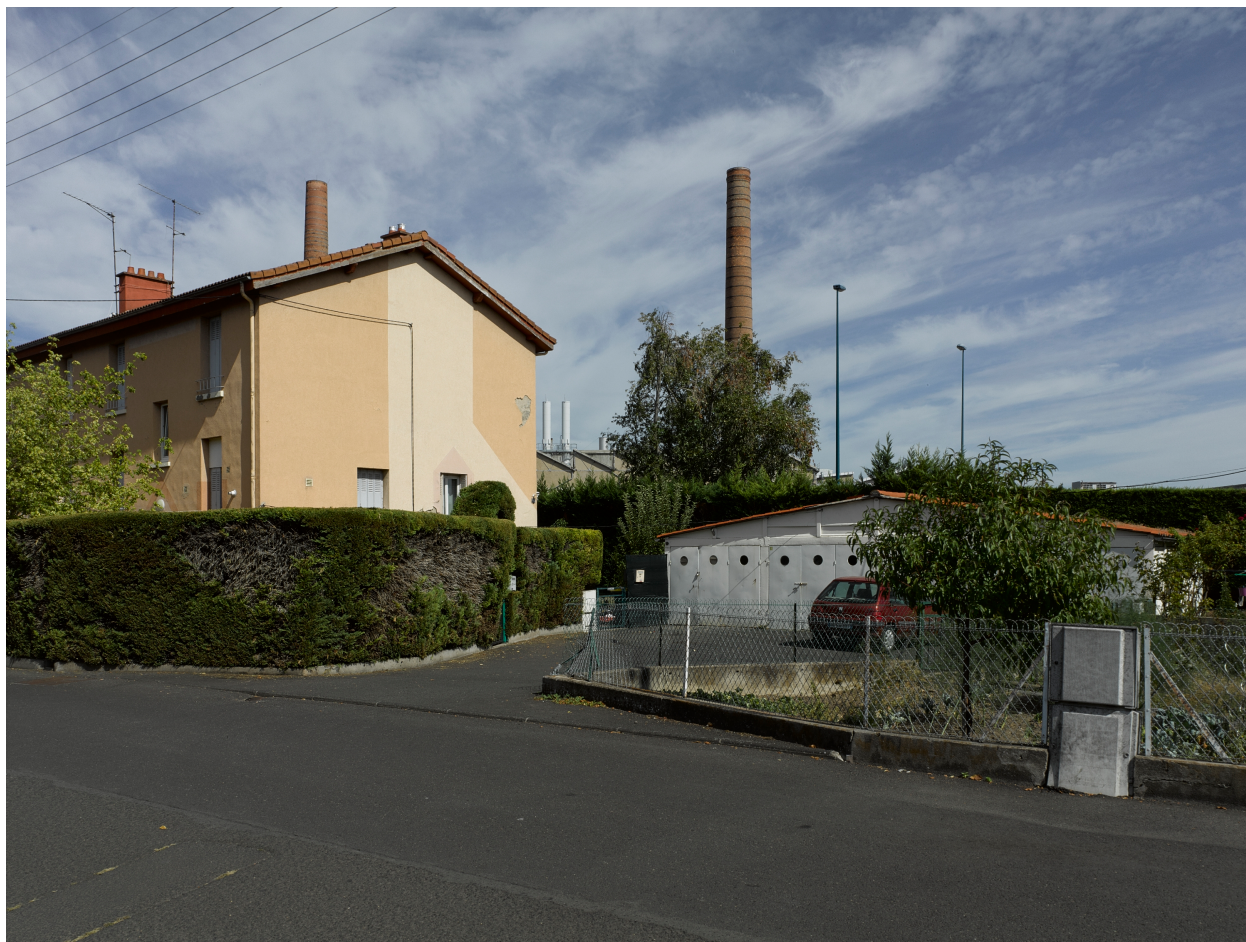
Une habitation de type O et ses garages, rue de la Tiretaine ; à l'arrière-plan, les cheminées de l'usine de Cataroux.
