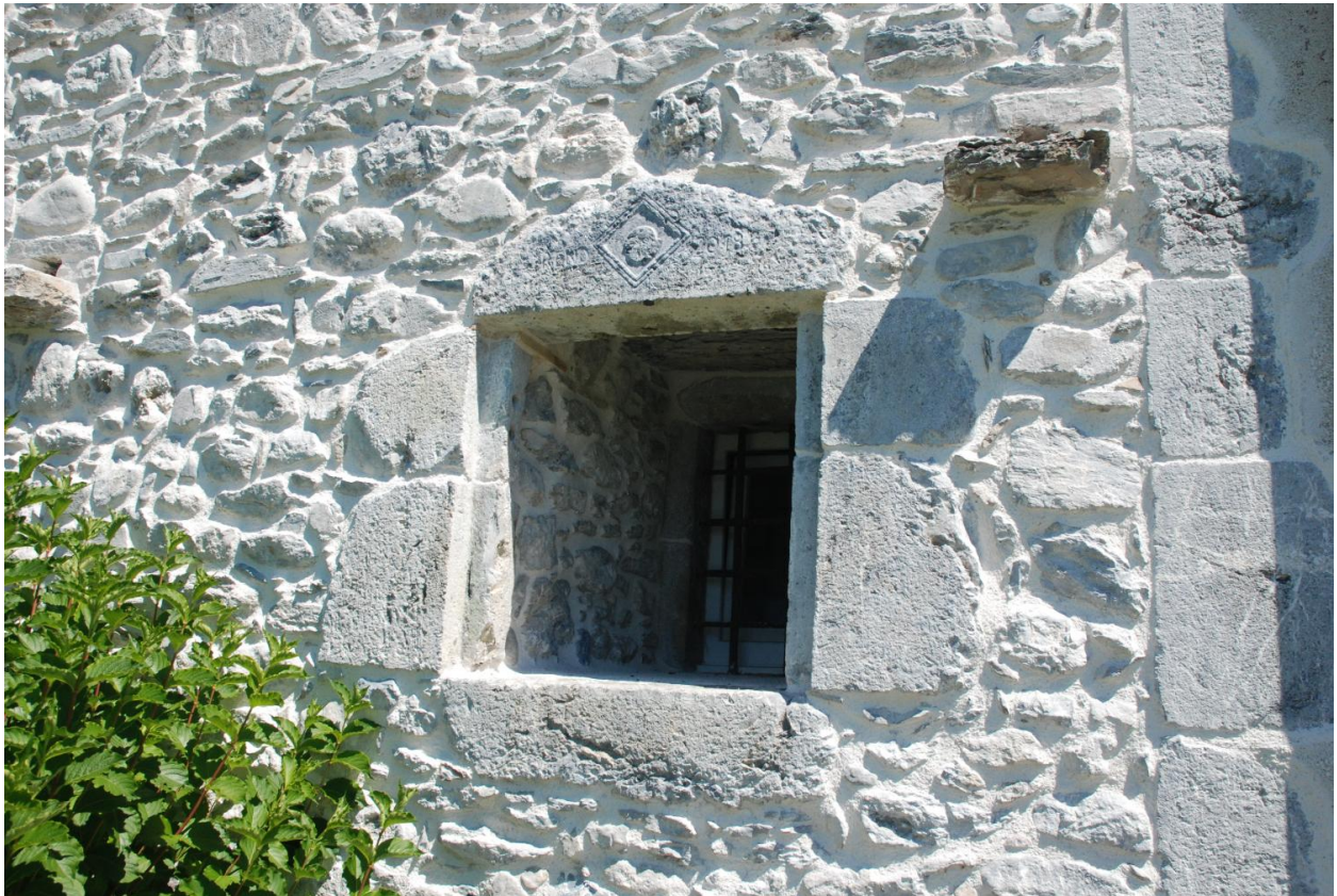
Bâtiment de dépendances, étage de soubassement, vue sud : détail de la fenêtre de la 1ère cave est.
