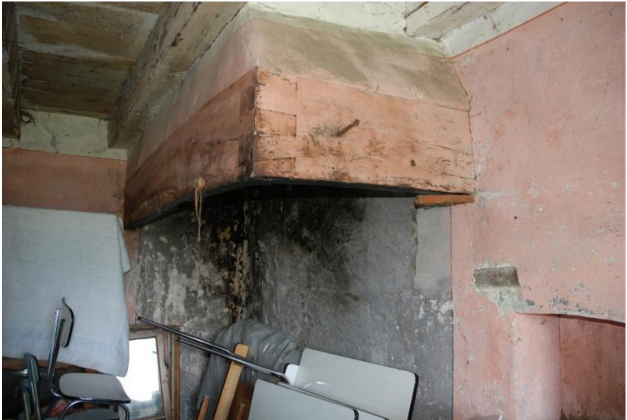
Vue intérieure de la cuisine : cheminée.
