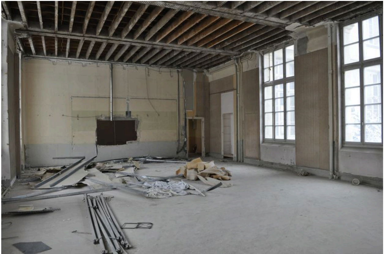
Vue des anciennes classes durant les travaux de 2010.
