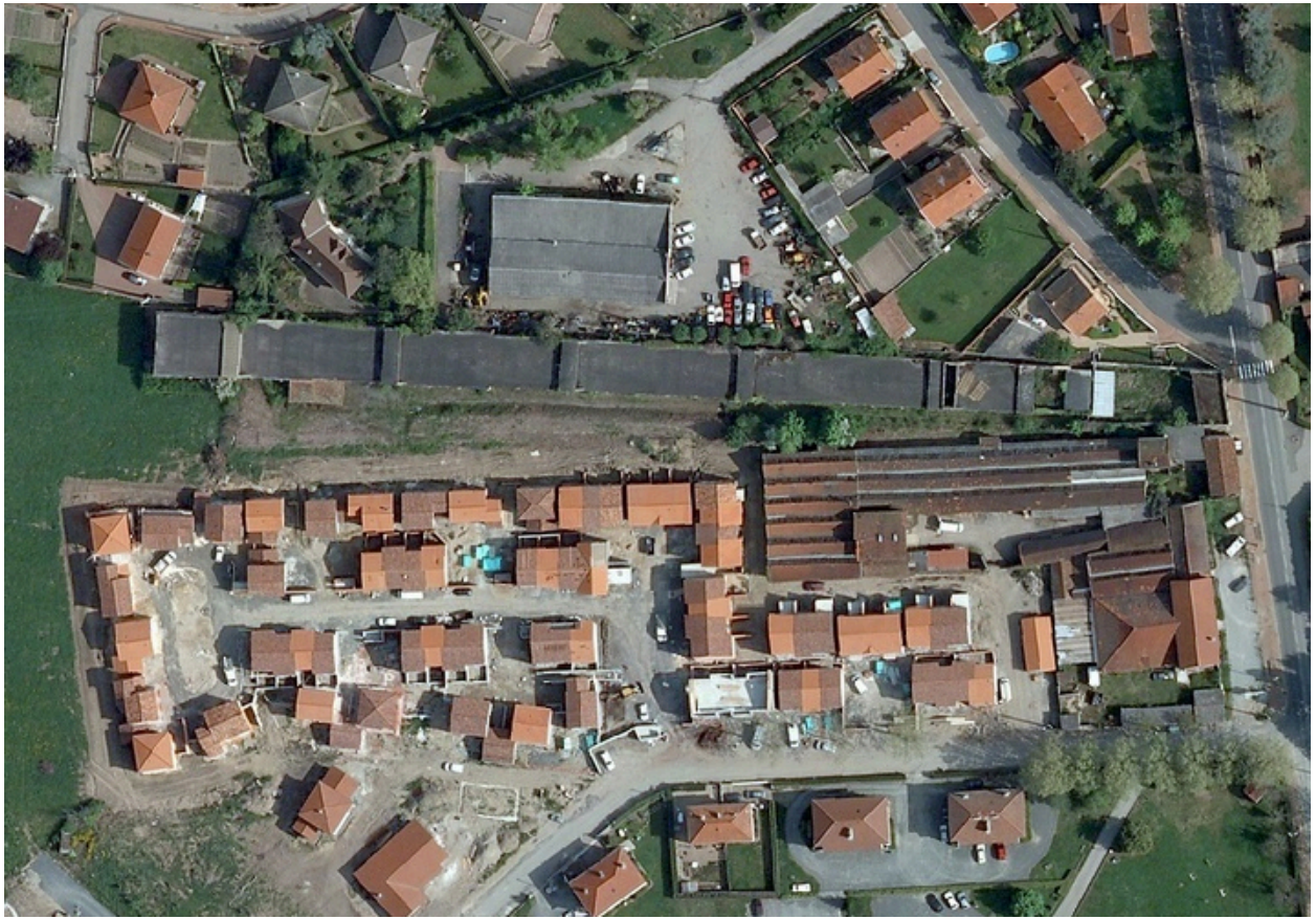
Vue aérienne (Mappy) du site des usines Nourrisson.
