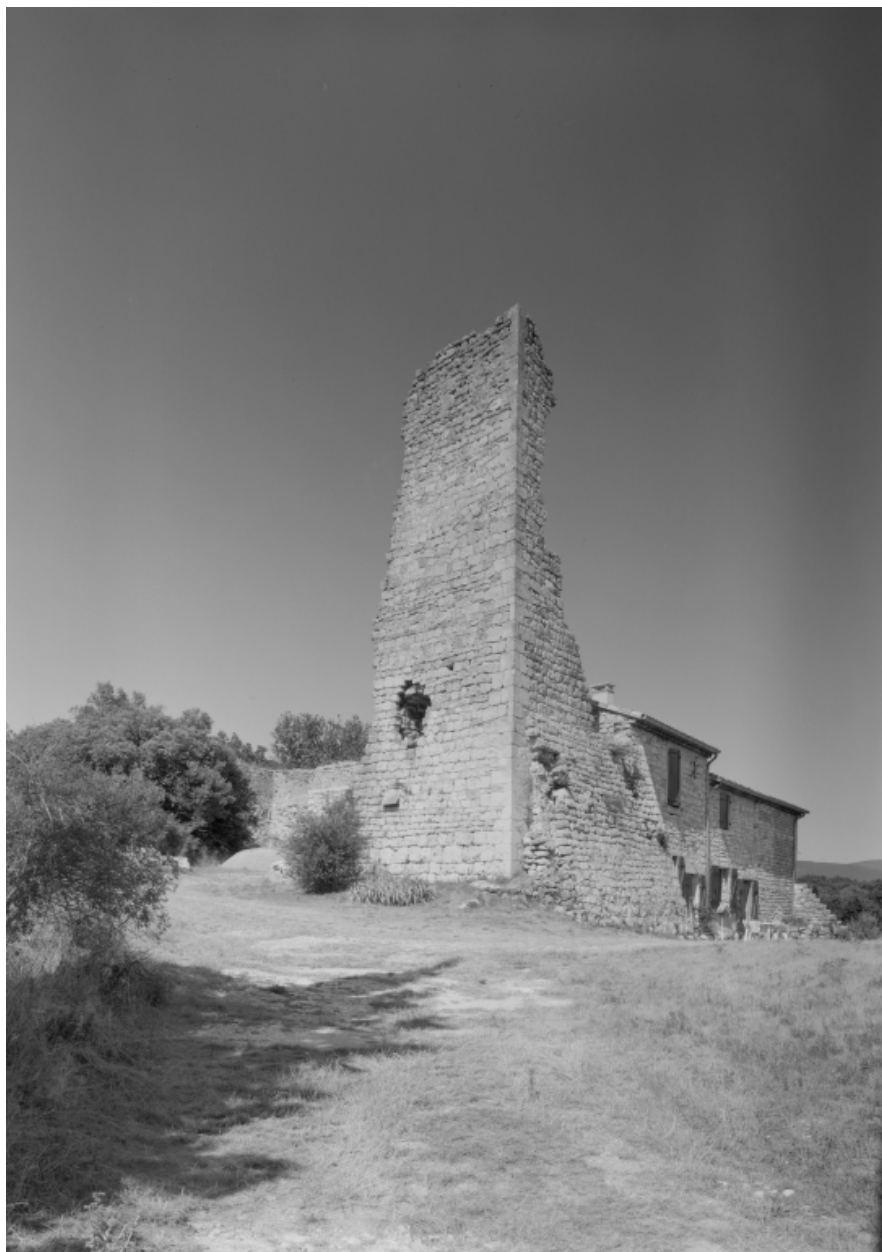
Tour en ruine de l'ancien prieuré, située dans l'une des fermes actuelles (A2 458/474).
