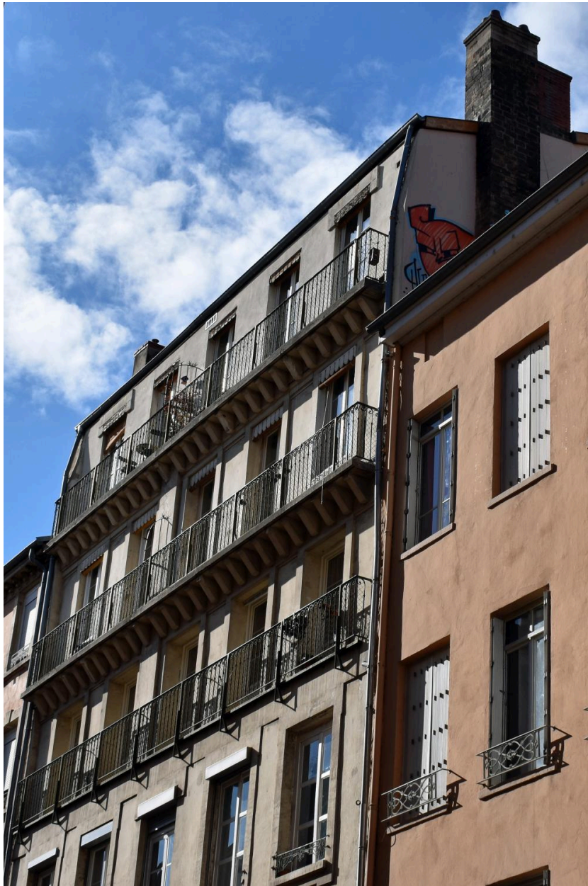
Elévation sur rue, détail des étages en surélévation
