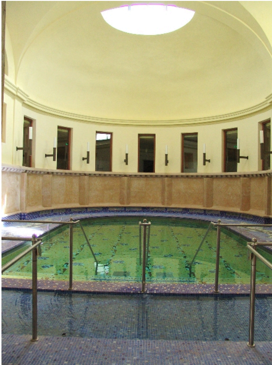
Piscine après restauration
