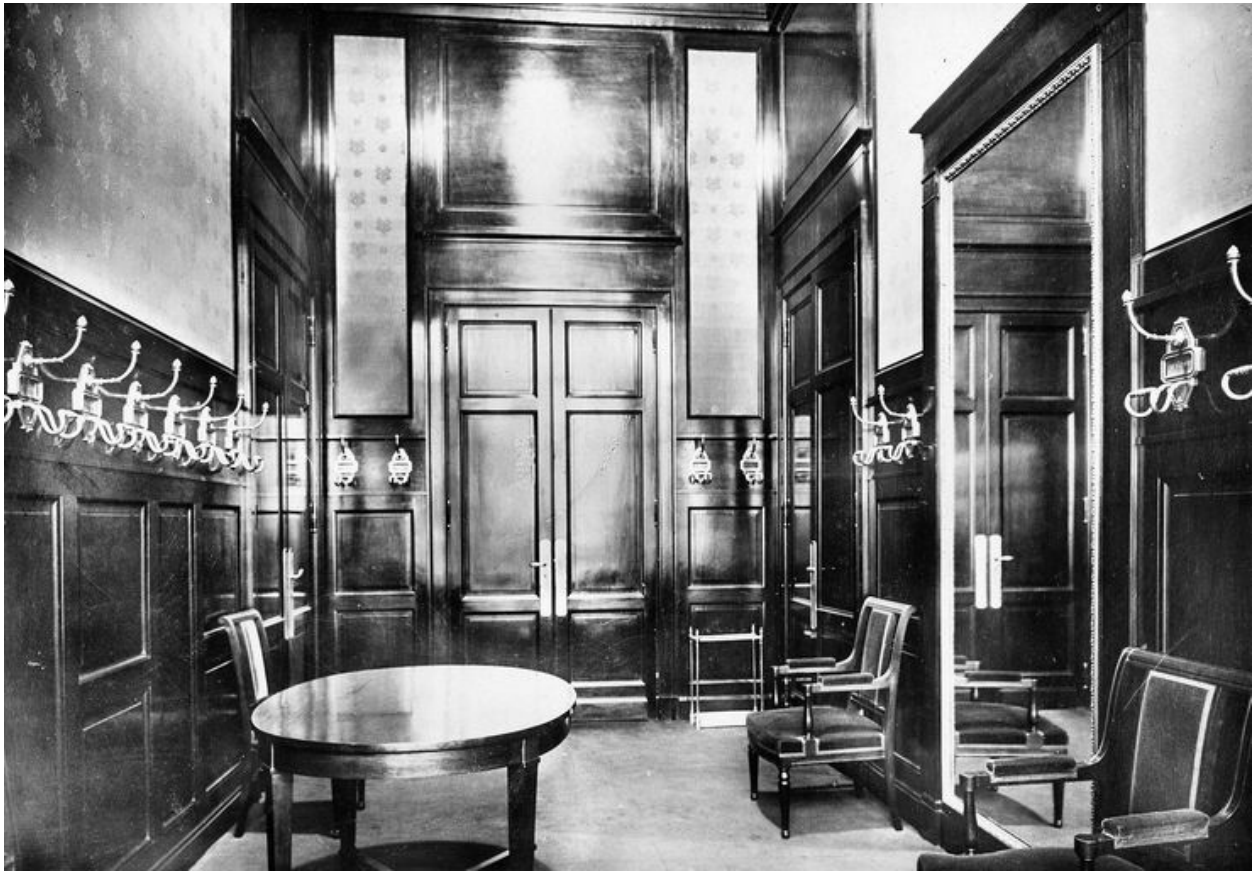
Vue de l'antichambre de la salle du conseil, en 1925 (Banque de France, PHAR, non coté, photographie).
