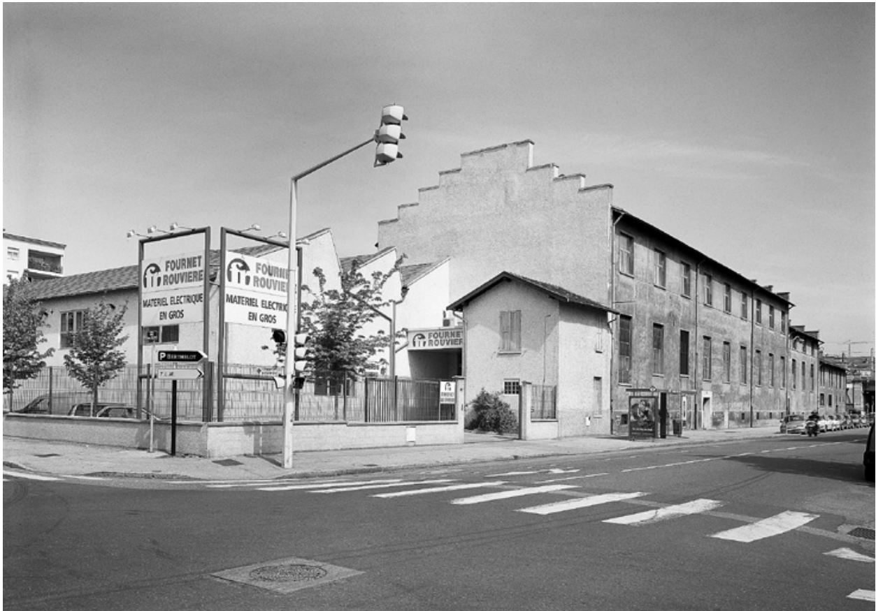
Vue d'ensemble sud-est
