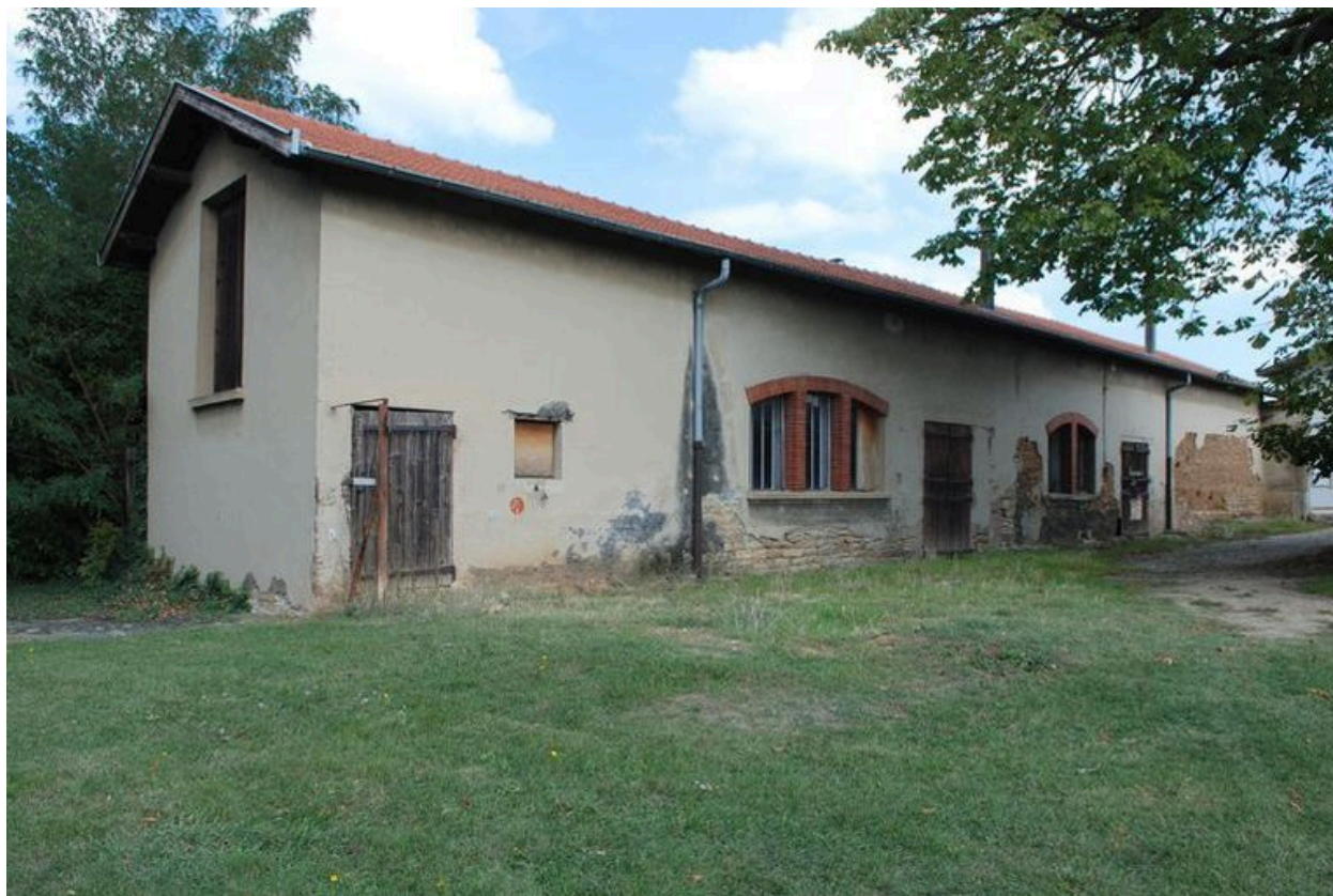
Bâtiment 235 (ancien cellier), vue depuis le sud-ouest
