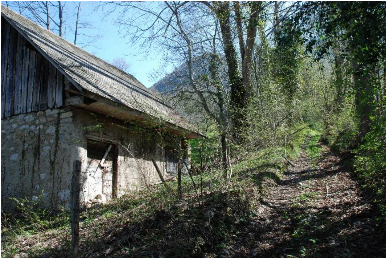
Vue de la grange-étable le long du chemin d'accès.
