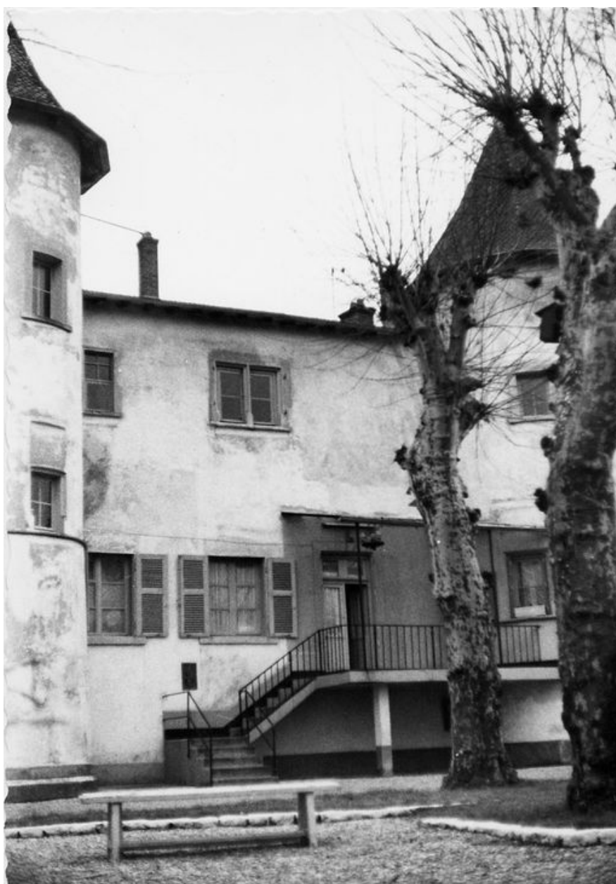
Elévation nord.Vue prise en 1970
