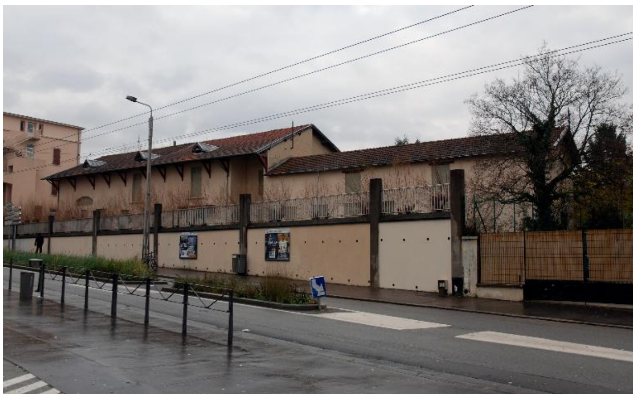
Anciens bâtiments agricoles, vue d'ensemble depuis le nord-ouest
