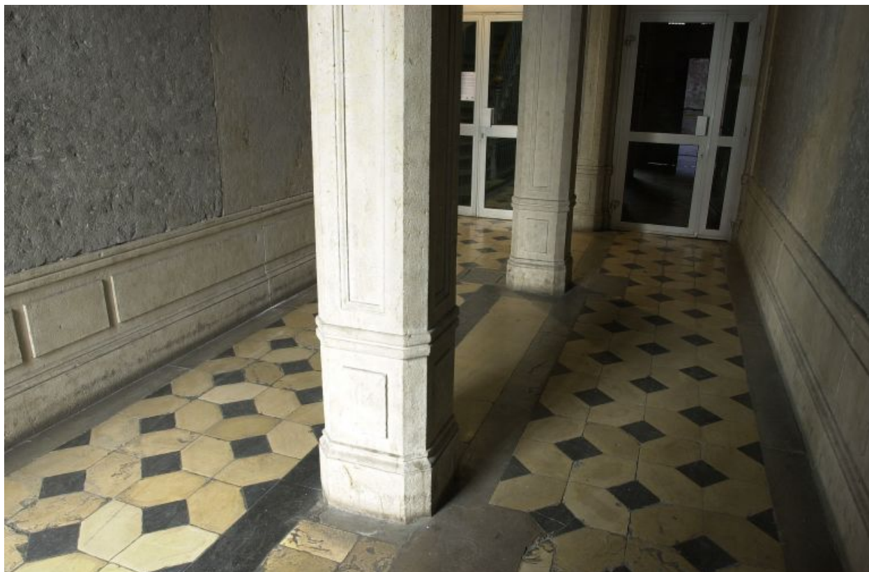
Allées des immeubles 11 et 13, rue Mercière, sol
