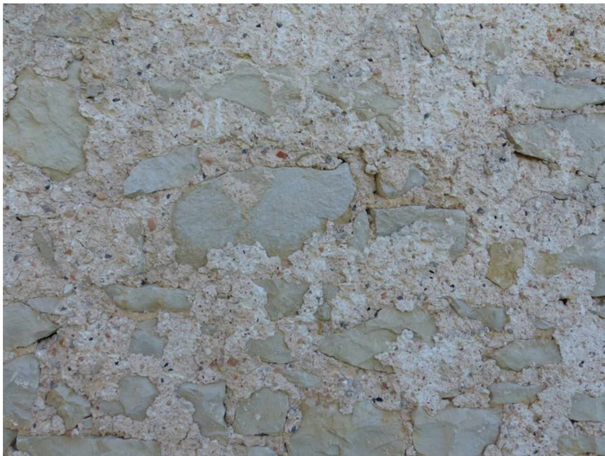
Elévation ouest, détail de l'enduit.
